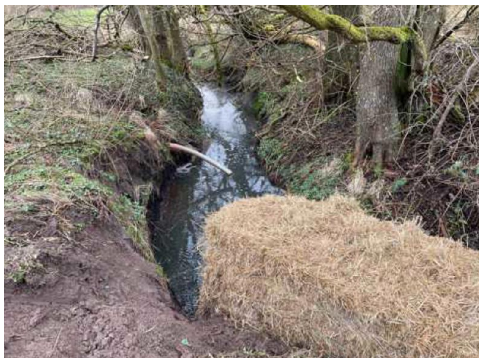
Opstemning med halmballe i åbent vandløb
