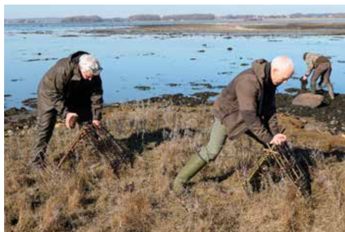
Arkitekten bag shelterkonstruktionen, Jørgen Schouboe, og jagtlinjelærer Jørn Nielsen fra Bråskovgård Efterskole presser/banker shelters – lavet af døde pilegrene – ned i jorden, så de ikke vælter i en eventuel storm.
