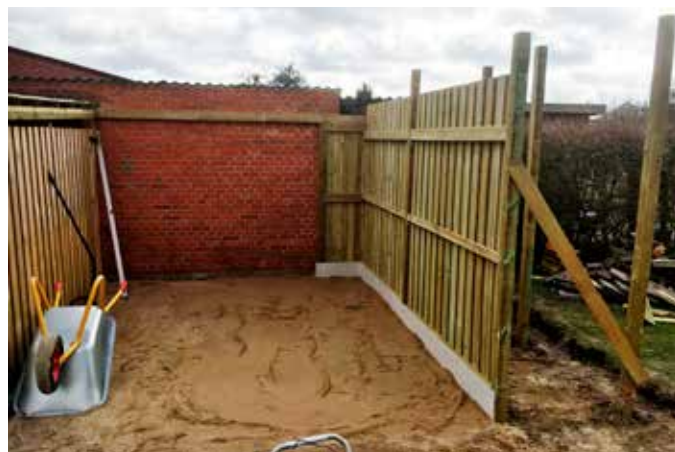
Har man flere hunde og flere løbegårde, er nem rengøring en vigtig detalje, derfor sættes kanten fra starten, så gårdene kan spules uden at ødelægge træværket.
