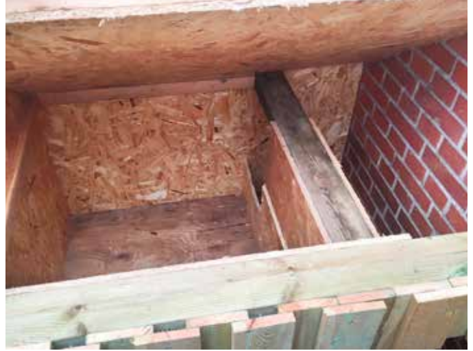
Hundehuset er godt isoleret og nemt at rengøre, men vigtigst er, at der er taget højde for vindfang. Det er afgørende, at hundene ikke får træk.
