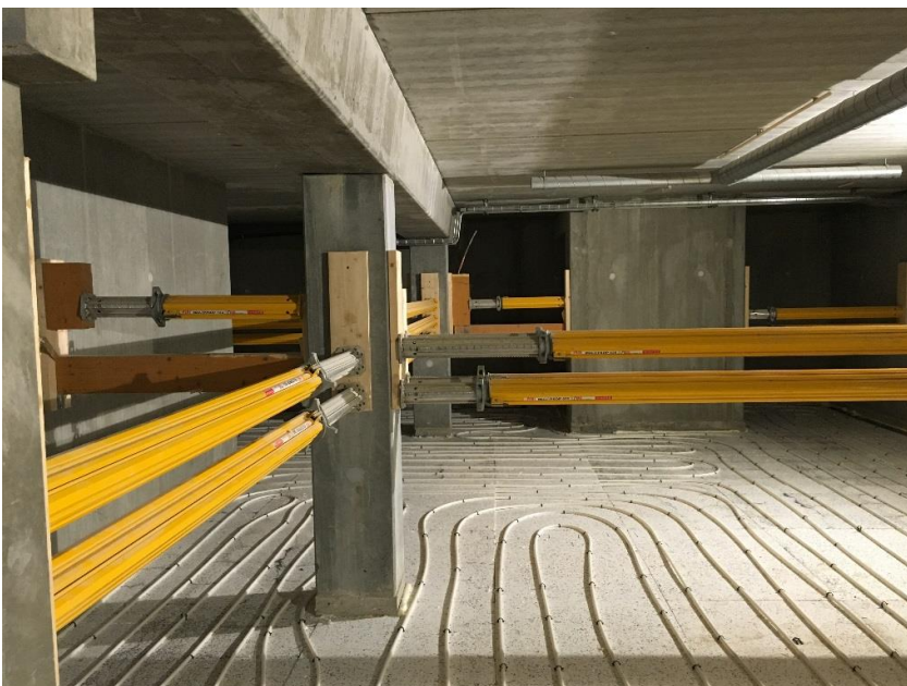
Vand under isoleringen under kældergulvet fik dette betonlåg til at revne og flere steder hæve sig over en halv meter!
