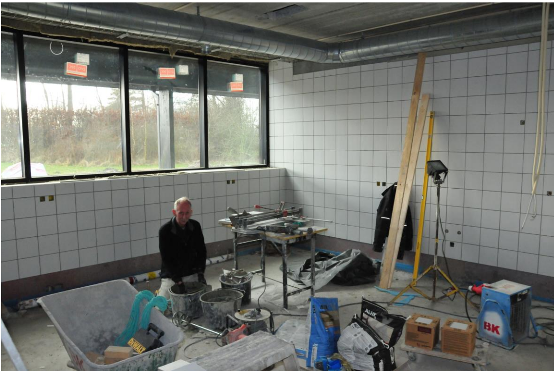
Her er Jens Aage Petersen fra firmaet Bent Klausen A/S i færd med at sætte fliser op i køkkenet i Uddannelsescentret.
