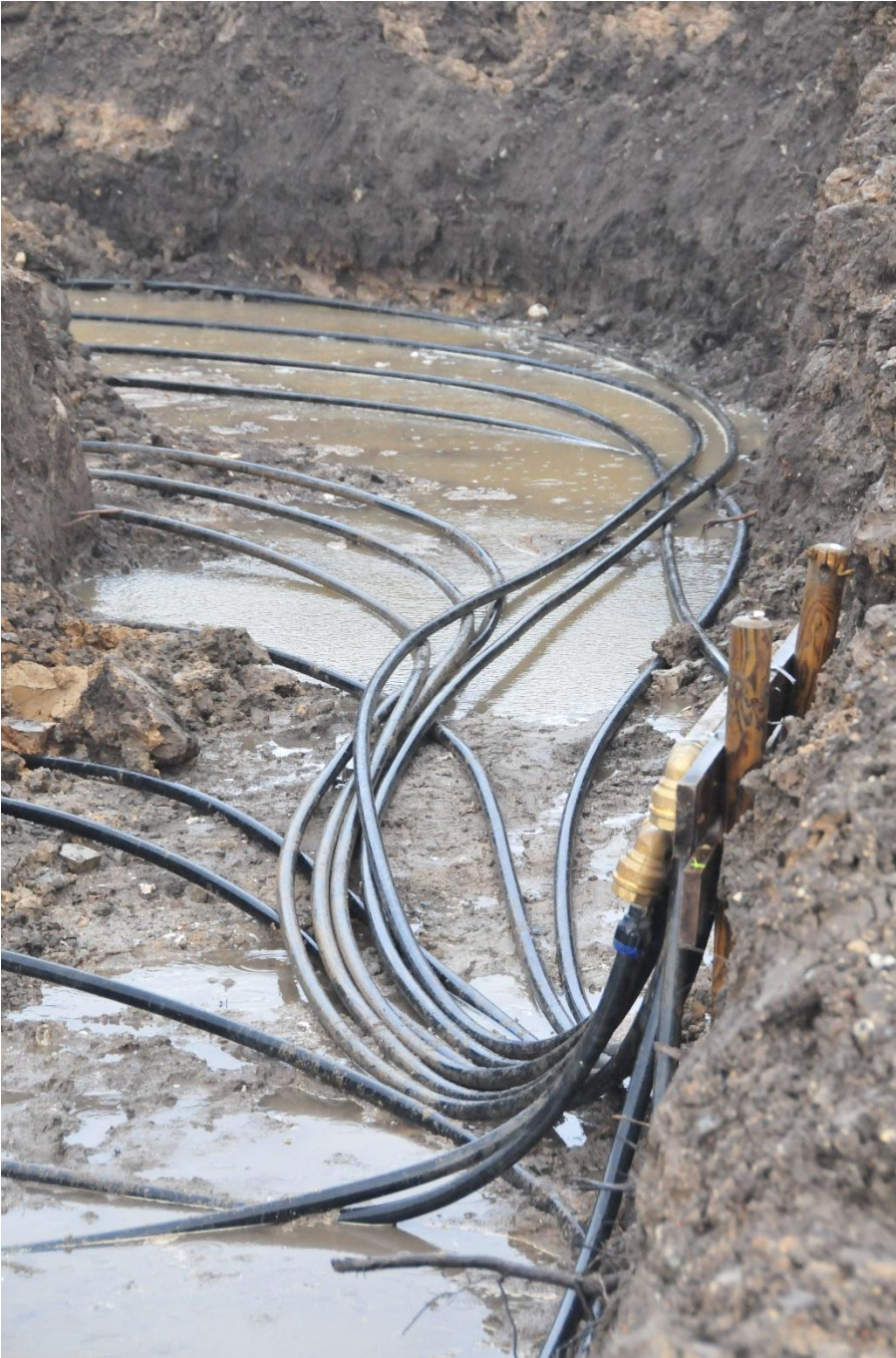
Jordvarmeslanger klar til at blive dækket med jord.
