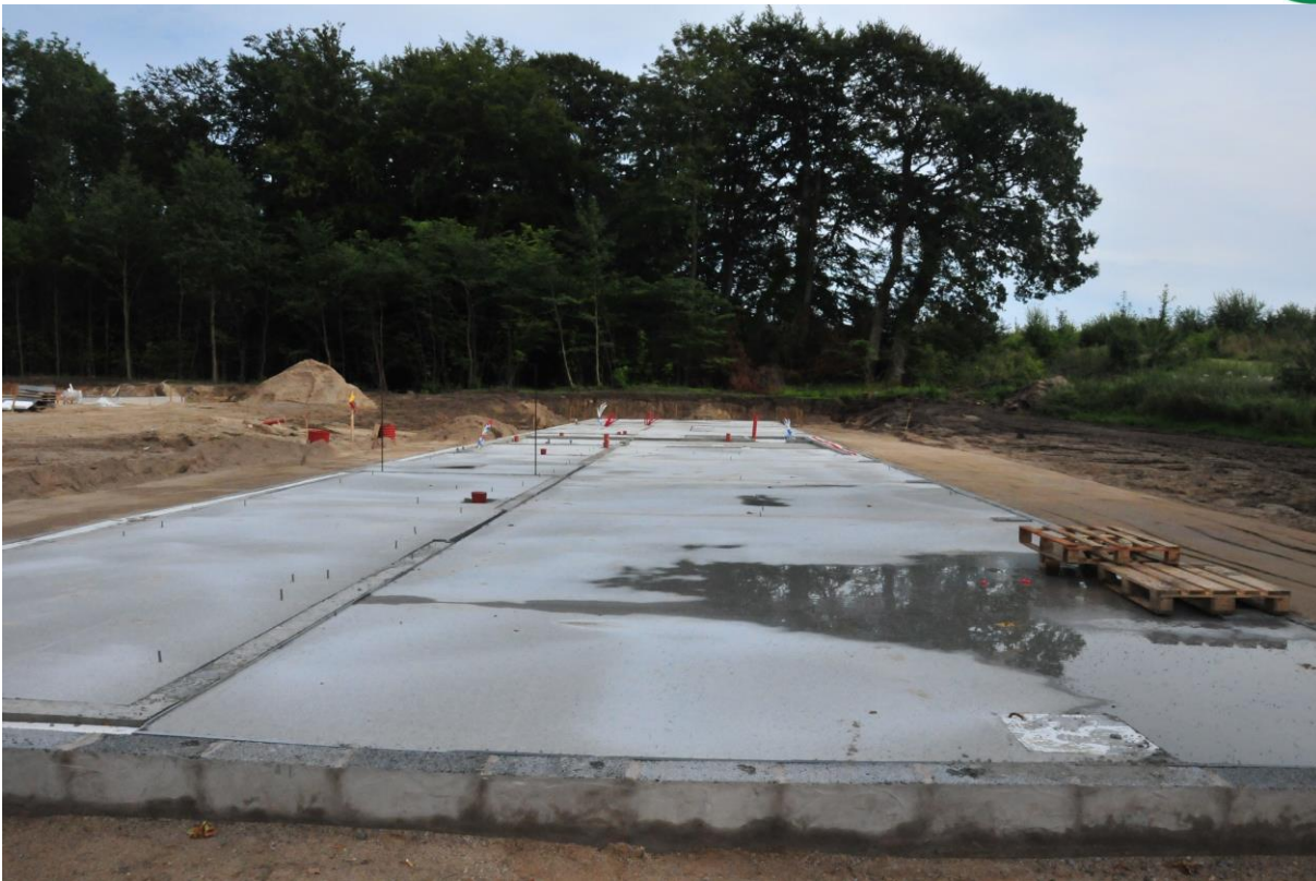
Uddannelsescentrets fundament og rågulv klar til montering af vægelementer.
