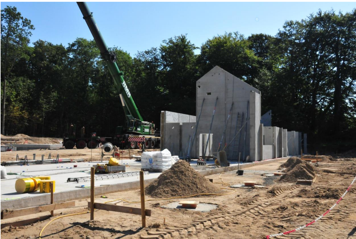
Så er Uddannelsescentret begyndt at skyde i vejret. De små betonfundamenter i højre side af billedet skal bære de limtræsøjler, der skal stå under hele tagsiden i begge sider af huset.
