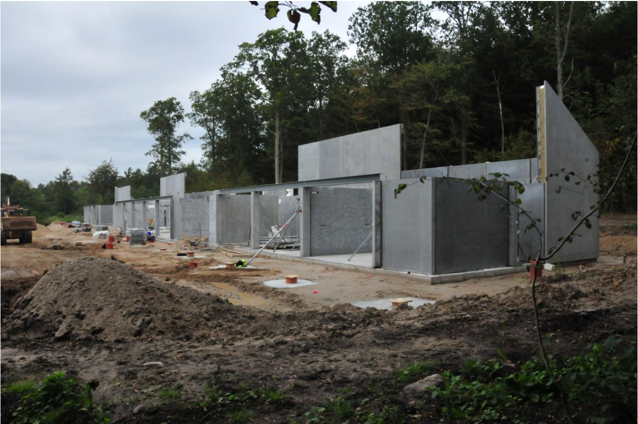
Videncentret set fra øst. Der er nu ved at være klargjort til montering af etagedæk.
