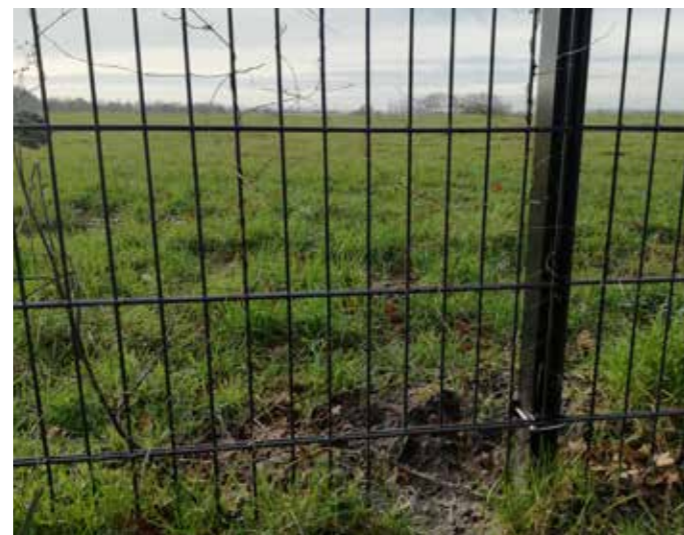
Hegnet er i 5-6 mm galvaniseret stål med dobbeltarmering på vandrette tråde, og nedgravet 0,5 meter for at forhindre, at vildsvin graver sig under hegnet.
