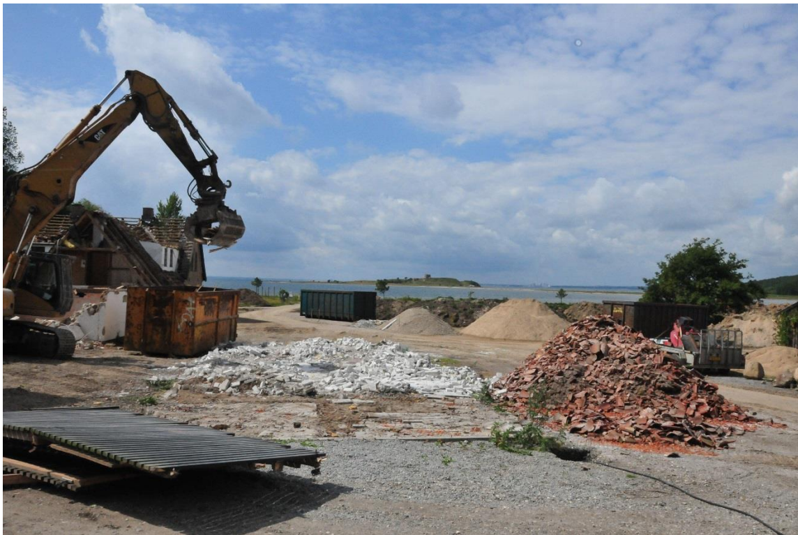
Her lå den gamle staldbygning. NU er der kun to dynger tilbage, - murstensbrokker og tegltagssmuld. Det er lige her det nye, lille Besøgscenter skal opføres.
