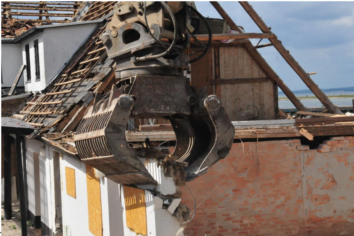
Maskinføreren fra P. Olesen & Sønner A/S udfører præcisionsarbejde med grabben. Selv brædder kan pilles af ét for ét.
