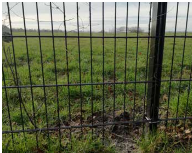
Hegnet er i 5-6 mm galvaniseret stål med dobbeltarmering på vandrette tråde, og nedgravet 0,5 meter for at forhindre, at vildsvin graver sig under hegnet.
